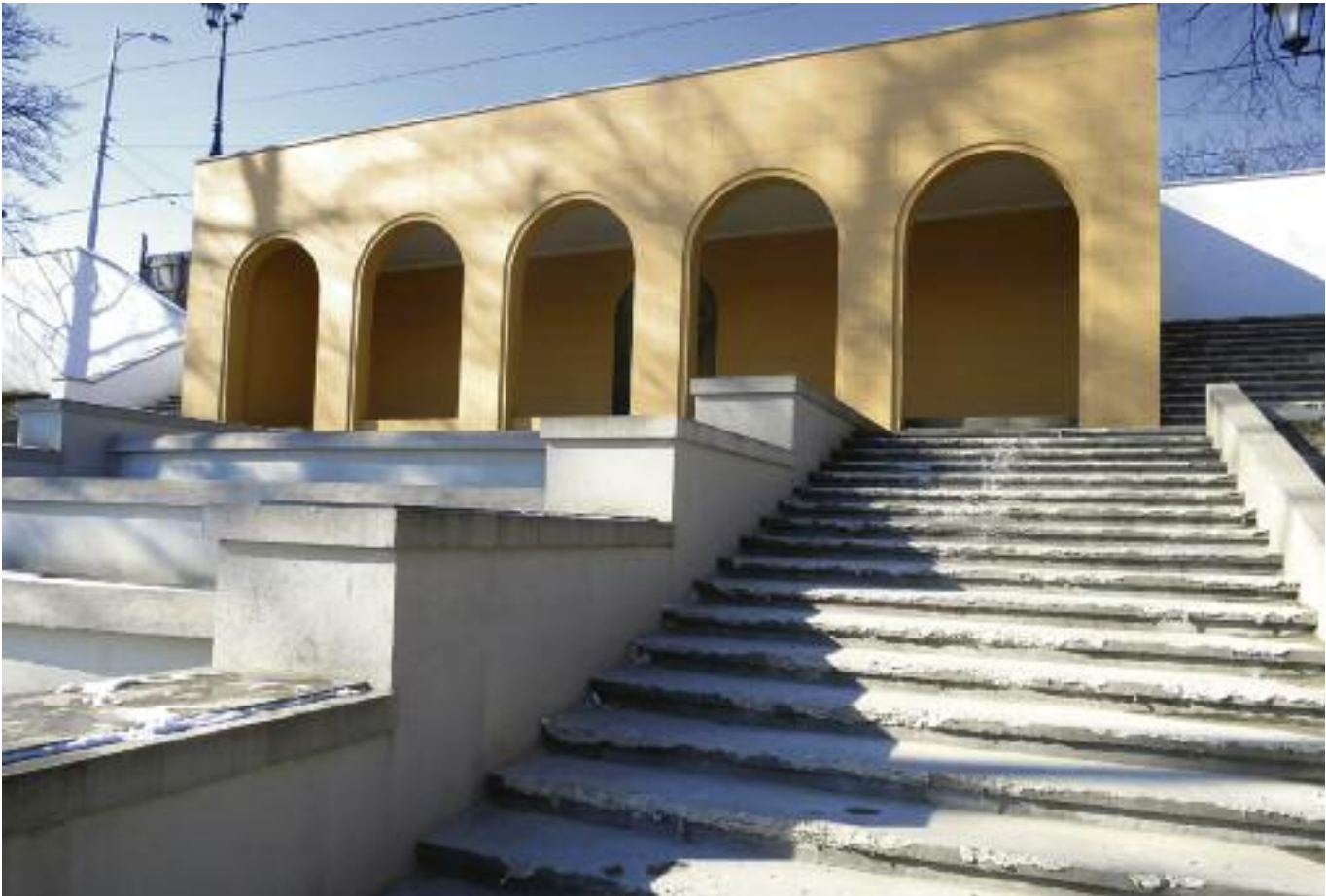
Neue Mängel kurz nach Fertigstellung: Bröckelnde Stufen bei den Schlossteichkaskaden
