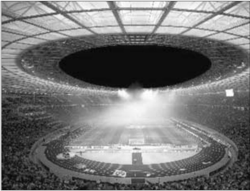
Olympiastadion in Berlin: Das von Werner March 1936 errichtete Stadion wurde vom Architekturbüro von Gerkan, Marg und Partner (gmp) 2004 behutsam modernisiert und erhielt eine Tribünenüberdachung mit einer Spannweite von umlaufend etwa 68 Metern. Foto: Marcus Bredt
